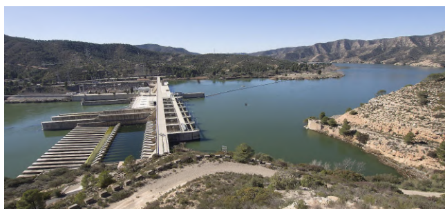
Central hidroelèctrica de Riba-roja d'Ebre
