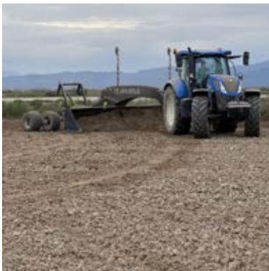
Figura 61. Tractor amb lacer nivellant el sòl. Font pròpia.
