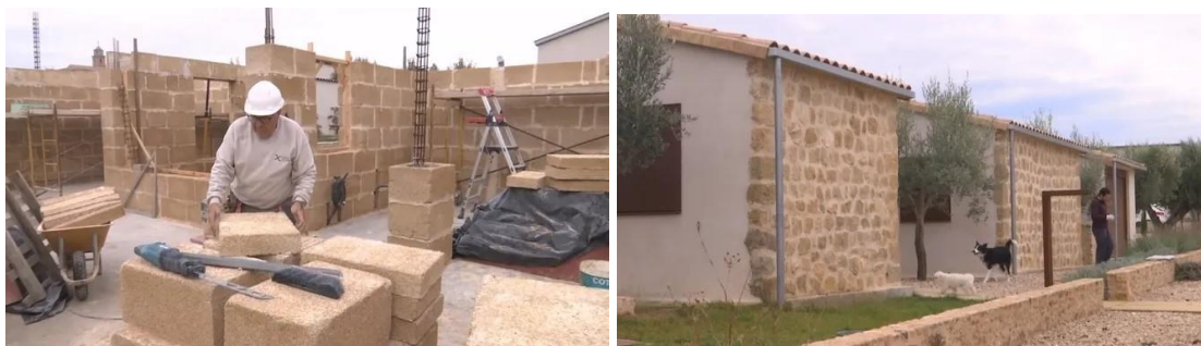
Figura 1 i 2. Construcció d'habitatges amb clofolla d'arròs. Font: www.ccma.cat
