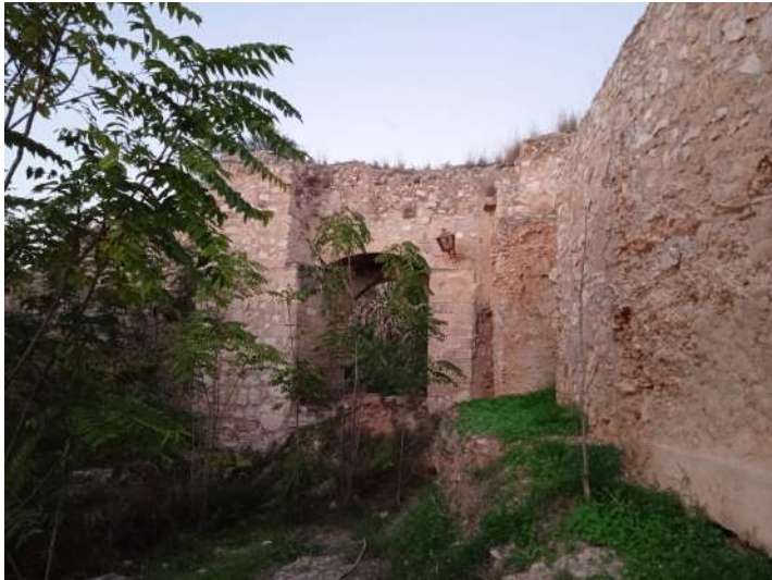
Fotografia: Accés al baluard del Carme o de la Victòria. Font: Pròpia.
