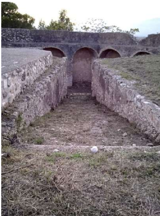
Fotografia: Rampa d'accés al pis superior. S'observa el camí de ronda.
